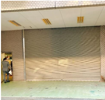
搬入口のシャッター
